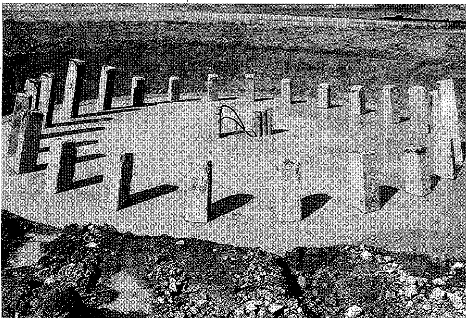
Nach der Rammung der Pfähle wird eine Sauberkeitsschicht eingebracht.
