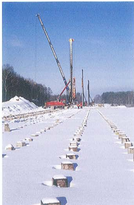
Bild 3 Centrum-Rammergeräte auf Linienbaustelle
