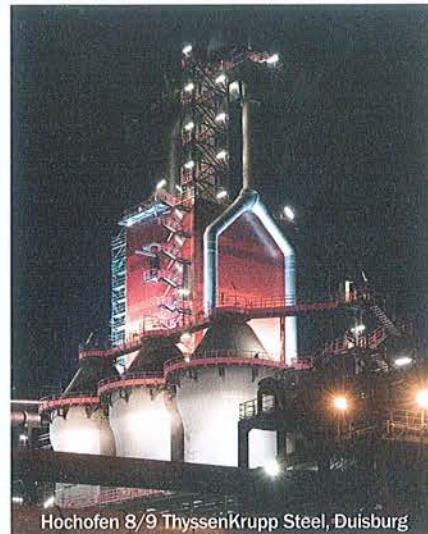
Hochofen 8/9 ThyssenKrupp Steel, Duisburg
