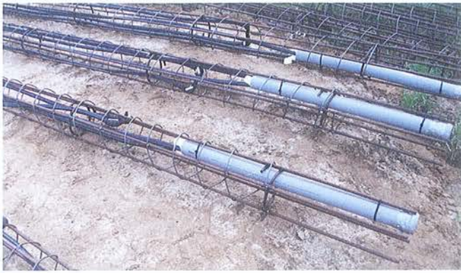
Bild 3 Teilweise wurden täglich über 120 Pfähle mit installierten Energieleitungen in den Boden gebracht.
