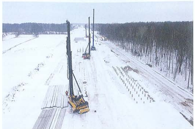
Bild 1 Rammarbeiten ohne Witterungseinschränkungen
