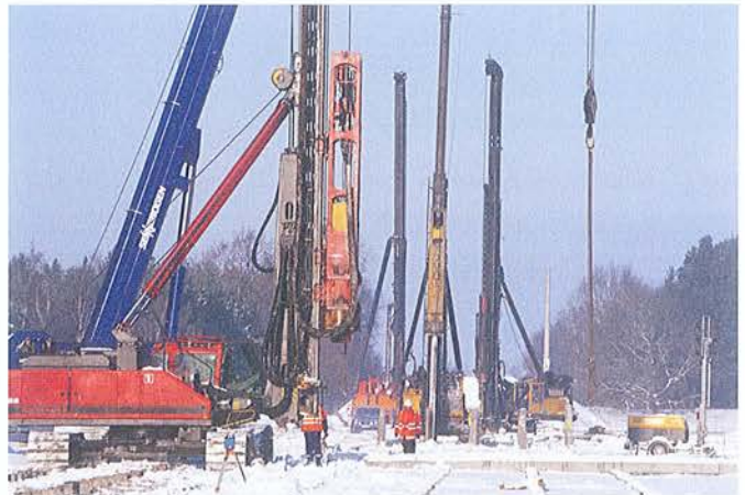
Bild 2 Kompakter Einsatz von Rammgeräten
