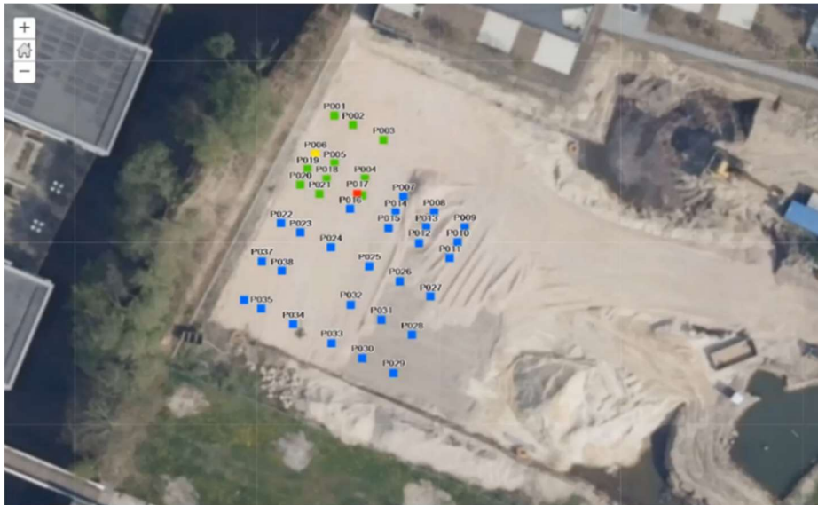
Bild 7 Farbliche Darstellung der gerammten Pfähle
