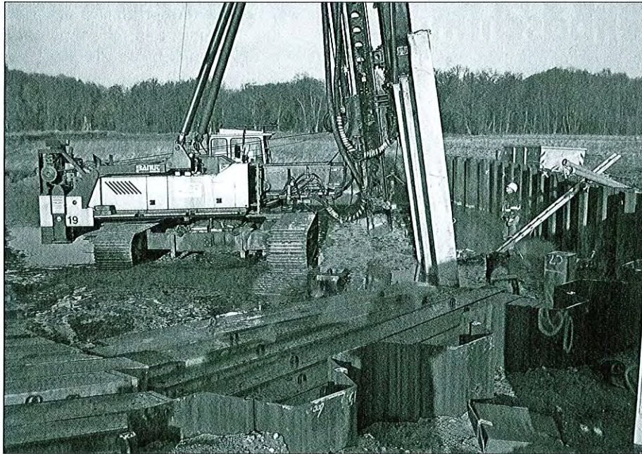
Allen gerammten Pfählen konnte aufgrund der Ergebnisse der statischen und dynamischen Pfahl-Probebelastungen die erforderliche Tragfähigkeit zugewiesen werden
