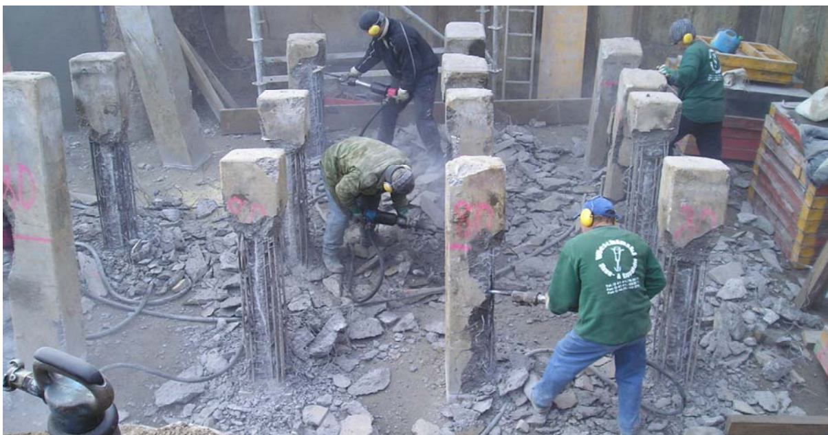
Bild 14 Kapparbeiten (Abstemmen der Pfahlköpfe) BW 515 Achse 20
