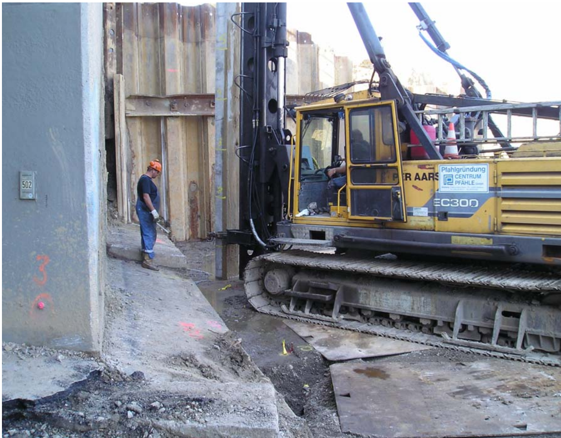
Bild 10 Ansetzen eines Pfahles beim Flügelfundament
