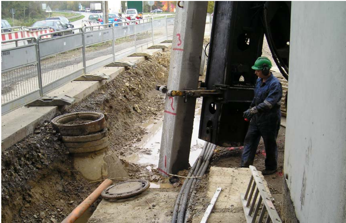
Bild 11 Neigungspfahl unmittelbar neben Leitungen
