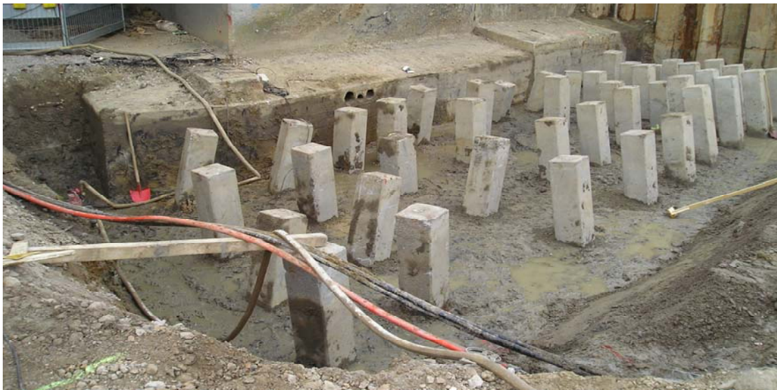
Bild 12 Pfahlköpfe mit Sauberkeitsschicht bei BW 502 Achse 20
