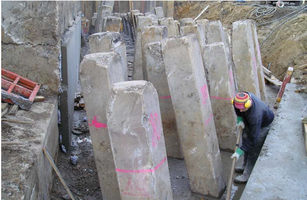
Bild 13 Aushub bei BW 515 Achse 20
