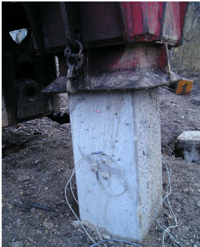
Bild 17 Detailansicht Pfahlkopf mit Rammhaube
