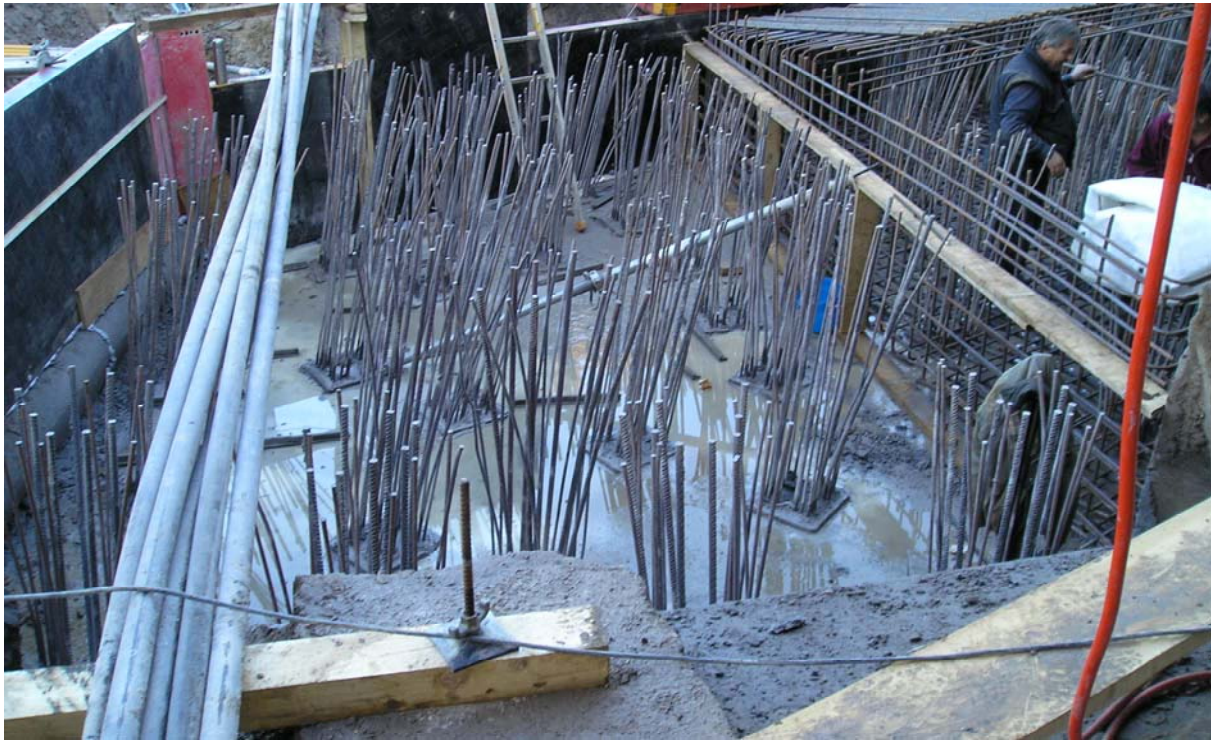
Bild 15 Fundament in der Bewehrungsphase (rechts) mit Pfahlbewehrung
