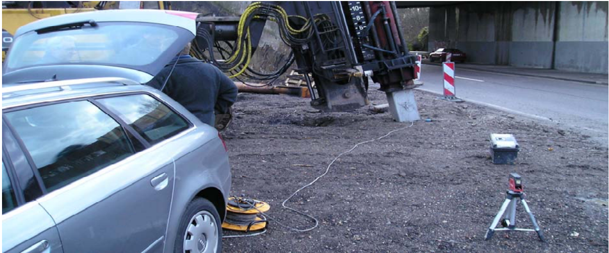
Bild 16 Vorgang der Probelastung, Totale
