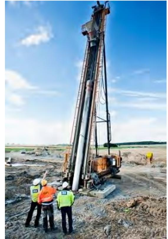
Simplex-Pfahl: Kopframmung eines geschlossenes Rohr (Fußplatte), Einbau der Bewehrung, Betonieren, Rohr ziehen
